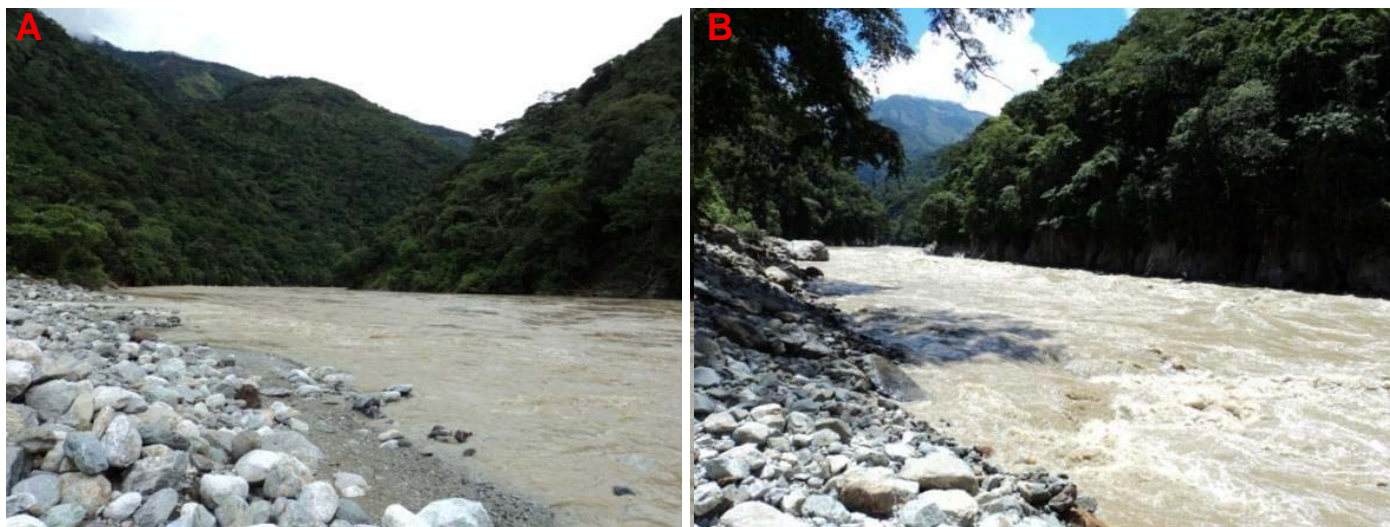
Foto 4. Derrubios de las quebradas El Pescado (A), margen derecha, km 3,8 y Los Rodriguez (B), margen derecha km 16,0 que permiten el estrechamiento recurrente del río Cauca y la consecuente activación de los raudales. Fotos Integral, sin fecha
