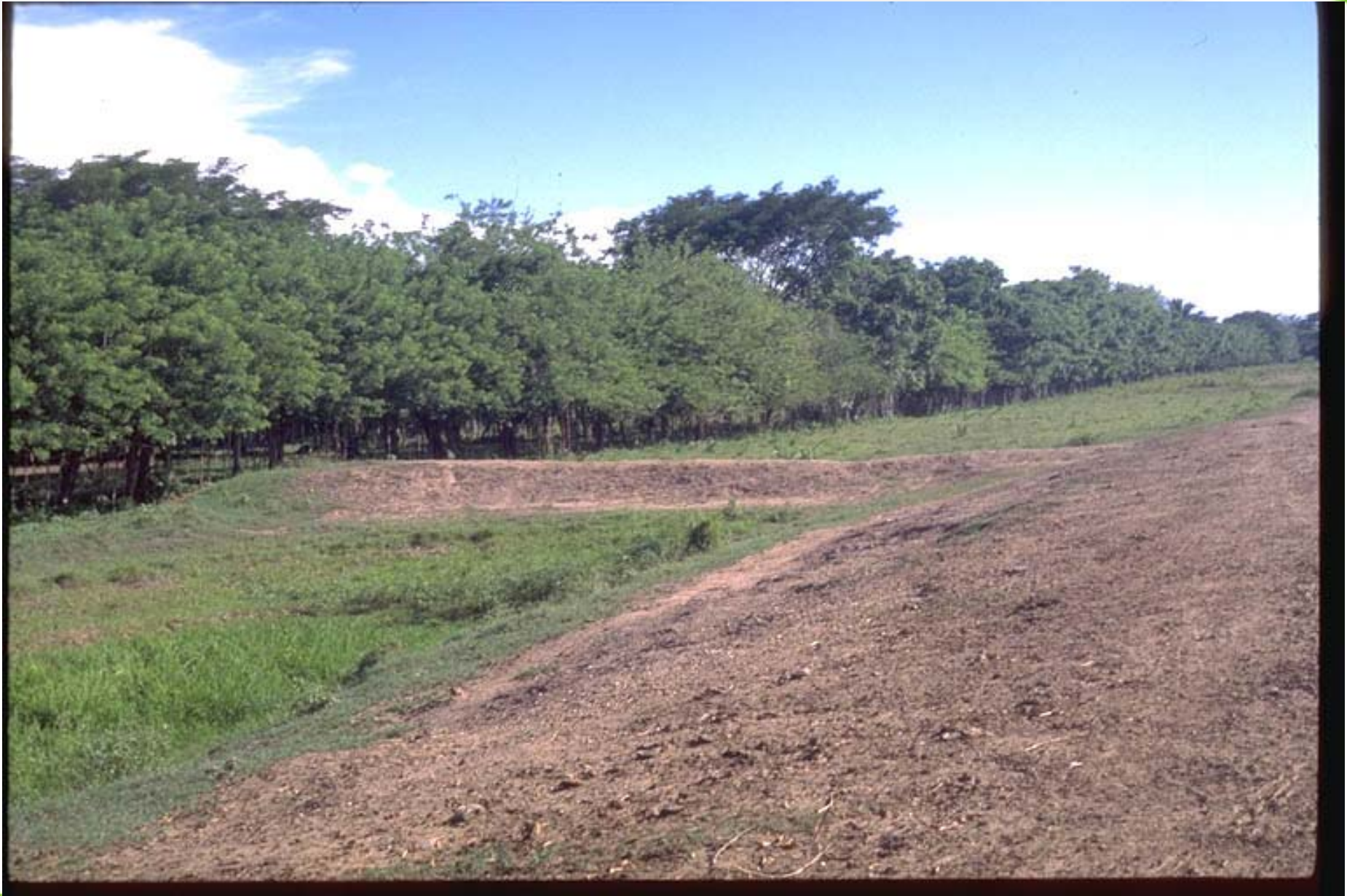
Construcción de diques y terraplenes, alrededores del caño La Puente, Isla de Mompox.
