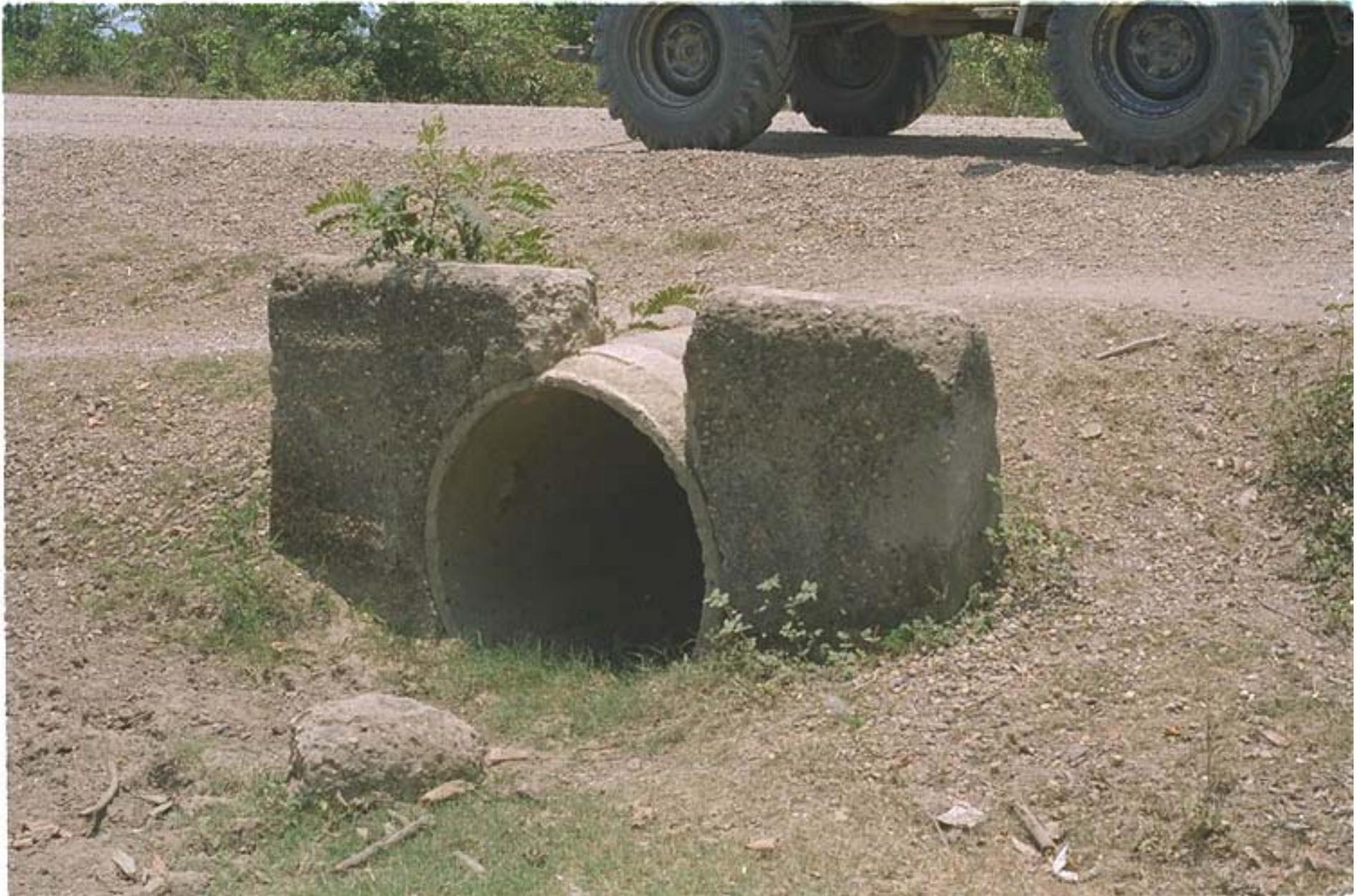
**Estructura ineficiente para drenaje, terraplen de la vía Mompox - Hatillo de Loba (Isla de Mompox).**
