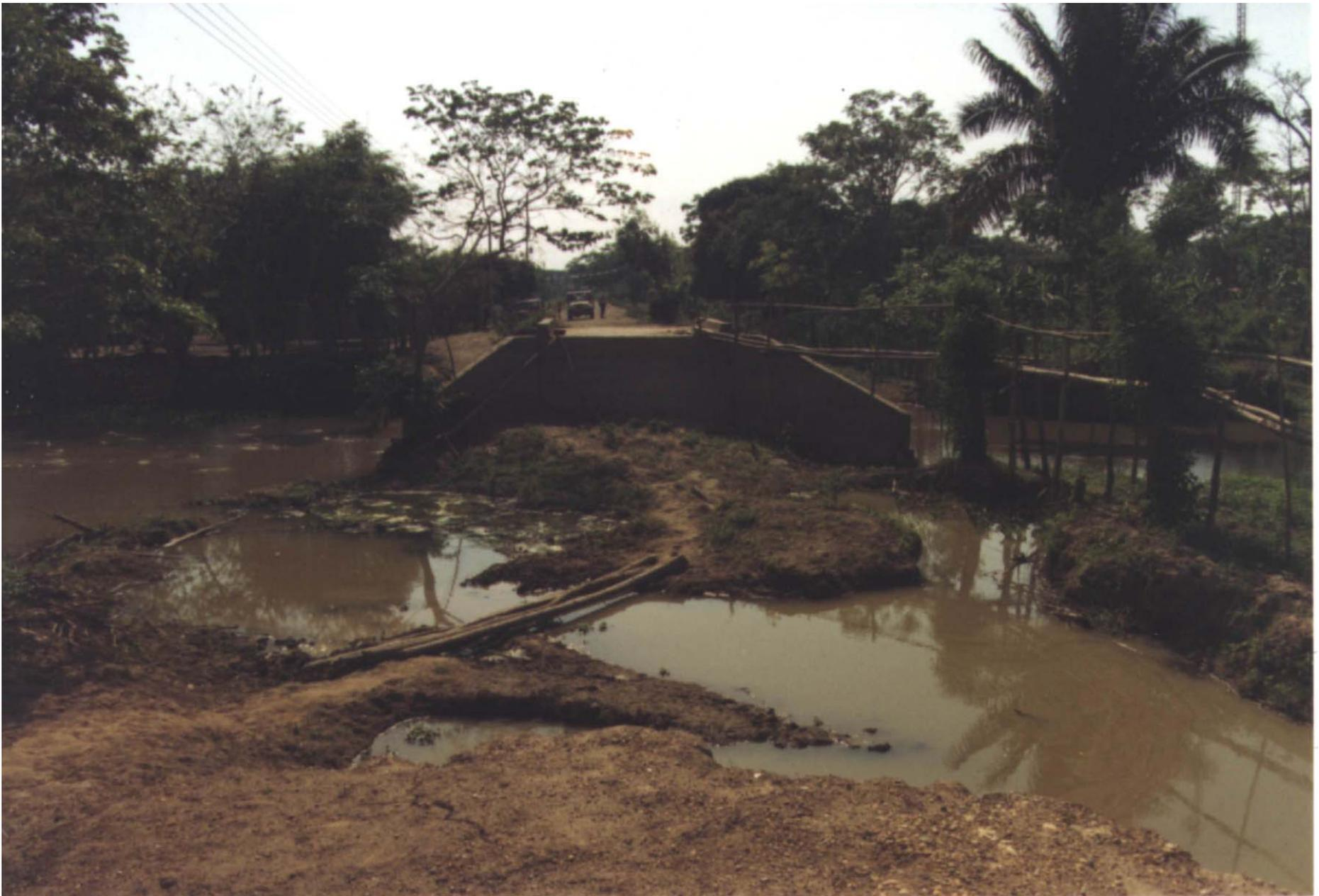
**Deterioro de la vía por interferencia del drenaje e ineficientes estructuras, sector Margarita (Isla de Mompox).**
