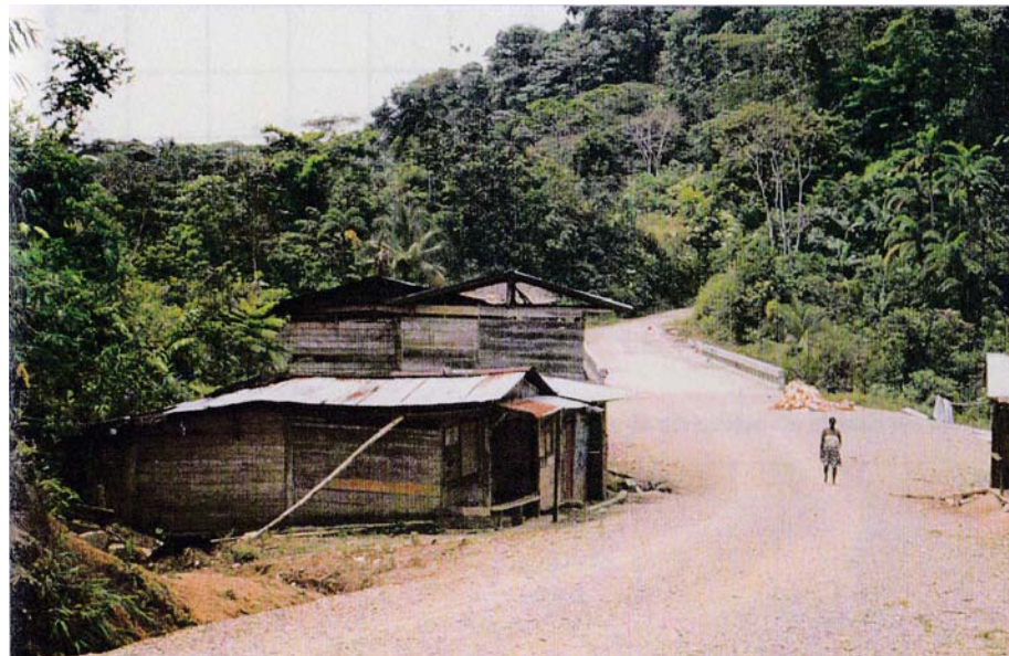
Foto 3. Asentamiento nuevo, adyacente a la banca de la vía, puente río Pató, en el tramo reciente. Foto O. Zapata
