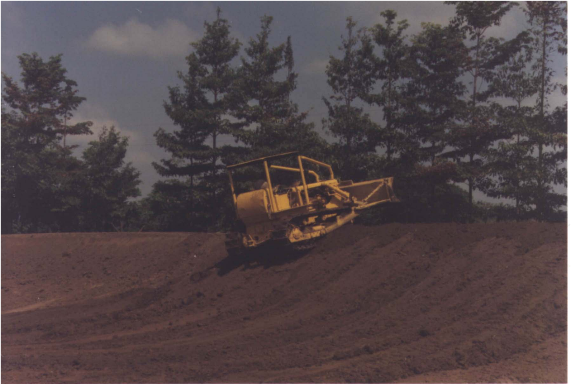
Construcción del terraplen para la vía entre Juana Sanchez y Hatillo de Loba (Isla de Mompox).
