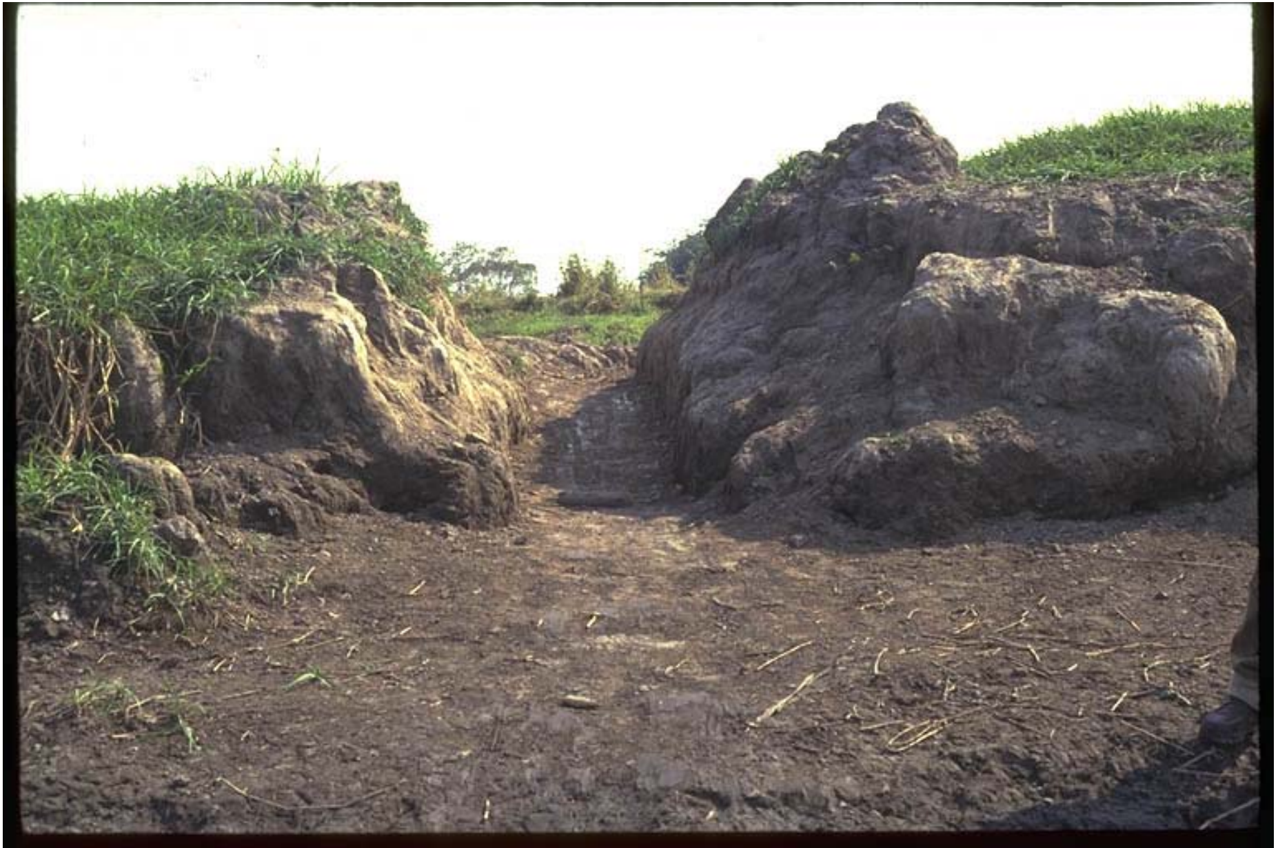
Canal artificial para permitir la colmatación o abonado de ciénaga, boca sobre la margen izquierda del brazo de Mompox.
